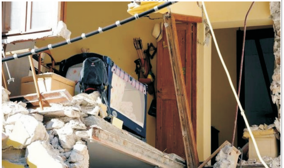
Una casa devastata dal sisma
